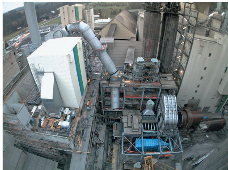
**13** Клинкерный холодильник уже опущен на свое место, головка печи смонтирована
