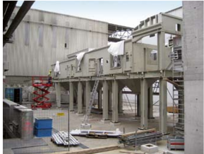
3 Assembly of the lower cooler housing with LPS pendulum stations Montage unteres Kühlergehäuse mit LPS-Pendelstationen
