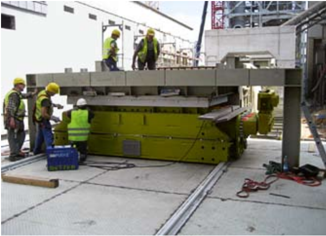
6 3-roll roll crusher – The crusher rolls are individually driven via reversible geared motors (11 kW) 3-Rollen Walzenbrecher – Brecherwalzen werden einzeln über reversierbare Getriebemotoren (11 kW) angetrieben
