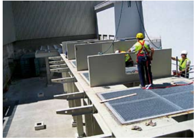
7 Steel platform as installation level for the pendulum grate cooler Stahlbauplattform als Installationsebene für den Pendelrostkühler
