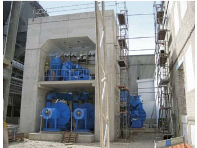
5 Fundamentarbeiten für Kühlluft-Ventilatoren und Pier #3 (links) sowie das fertige Pier mit 3 Kühlerventilatoren auf zwei Ebenen
