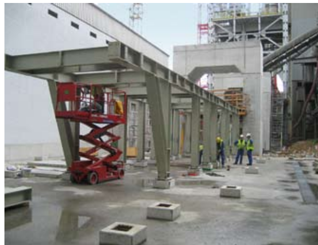
4 Assembly of a steel platform • Montage einer Stahlplattform
